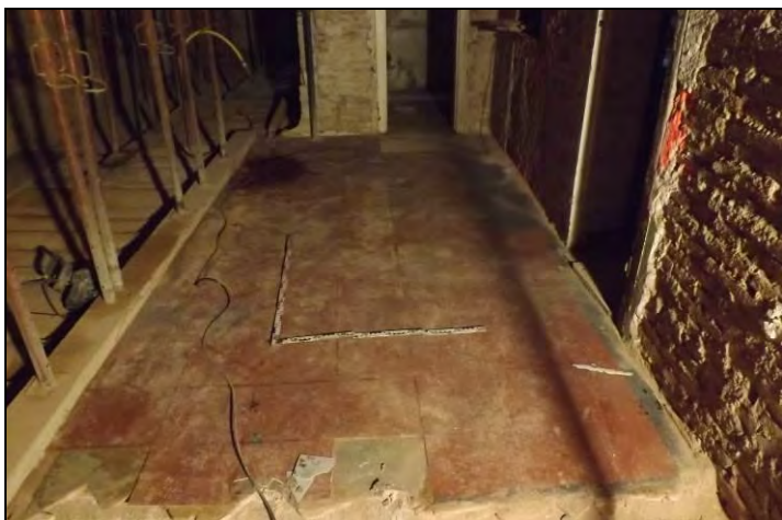
Paviment dels Àmbit 23 i 24 i a la dreta l'embigat i els revoltons
