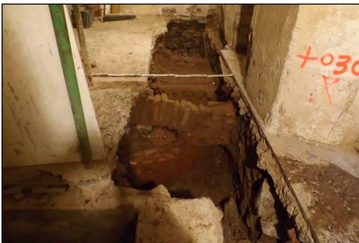
Vista general de la rasa amb l'arqueta UE 12006, l'arc de descàrrega UE 12010 i la claveguera UE 12011
