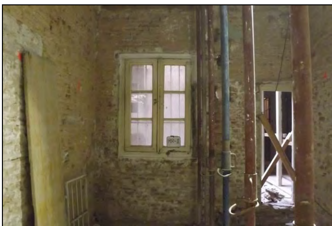
Vista del mur MR-I
