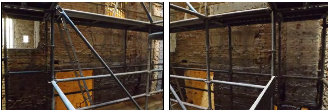
Planta Primera. Nivell inferior. Mur Sud. Croquis i fotos generals
