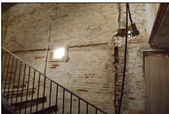
Dues vistes generals en alçat del mur Sud amb el reforç de ferro
