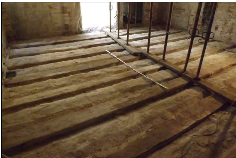
Vist dels forjats dels Àmbits 2a i 2b
