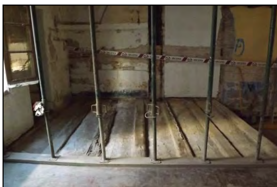
Àmbit 2a: L'esquerra el paviment vinílic i a la dreta els revoltons. A sota Àmbit 2a i 2b
