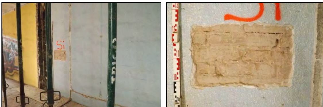
A l'esquerra vista general i a la dreta detall de la CP 17
