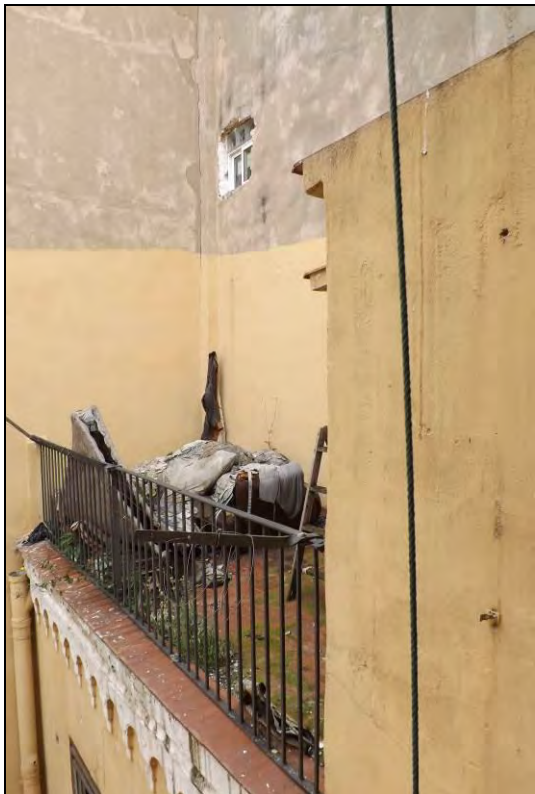
Vista del terrat que ocupa l'Àmbit 3
