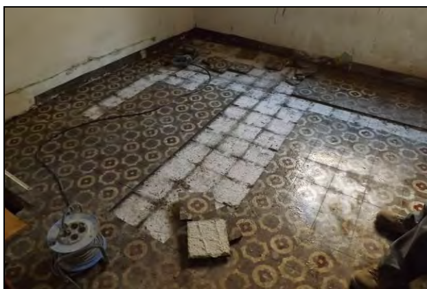
L'esquerra el paviment hidràulic i a la dreta el procés d'extracció
