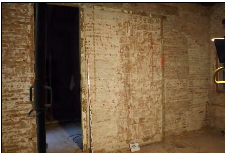
Vista del mur MR-T
