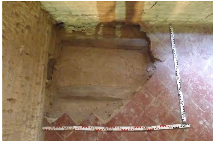
Vista de la Cala 20 i de la Cala 21
