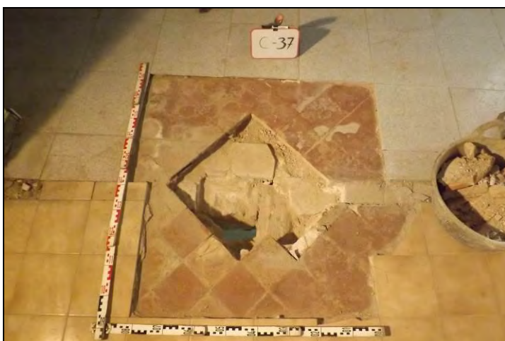
Vista de la Cala 37
