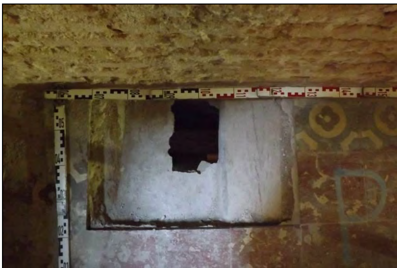
Vista de la Cala 17
