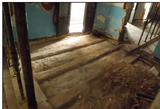
Vista del forjat sota l'Àmbit 8 amb els revoltos
