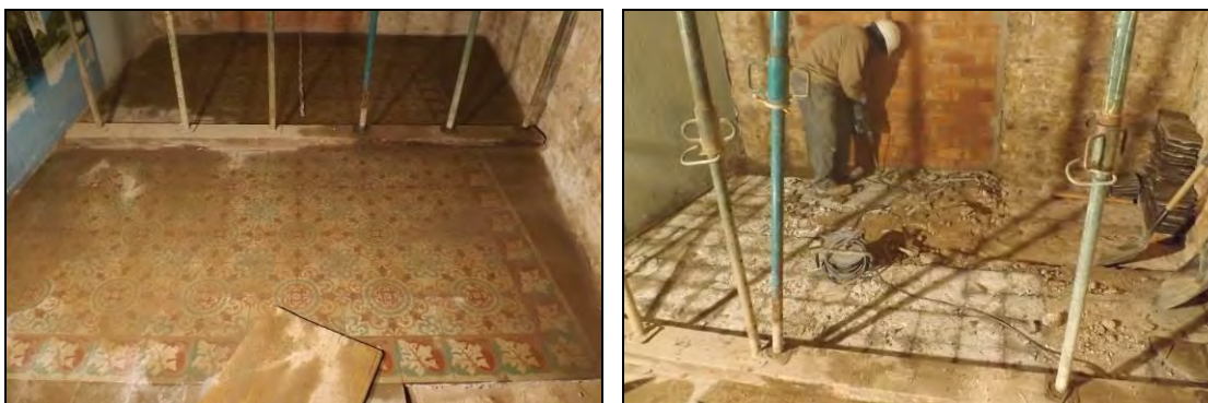
Vista del paviment hidràulic i detall de la reparació a Àmbit 14
