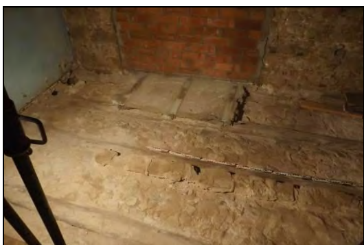
Vista de l'embigat amb la reparació i els envans de re creixement i vista general
