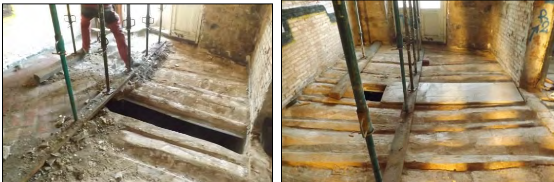
Vista de l'Àmbit 25 a i 25b amb el paviment i el forjat de bigues de fusta
