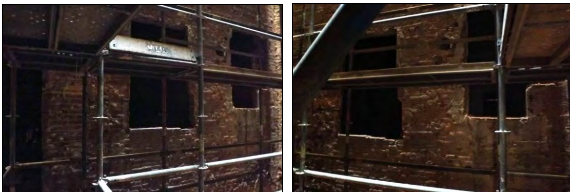
Replà Planta Principal i Altell. Mur Nord
