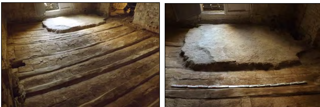
Vista general de l'embigat de l'Àmbit 26 i detall de la reparació
