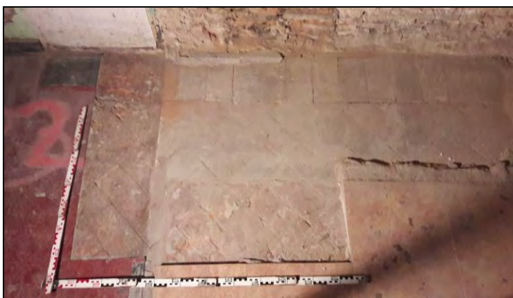
Vista de la Cala 6
