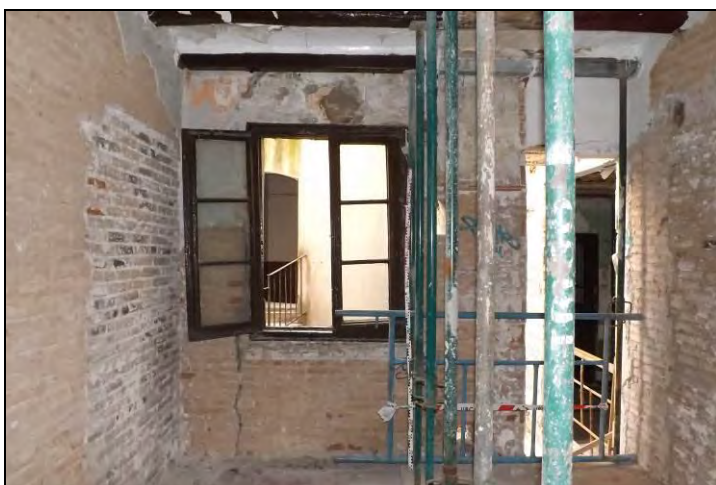
Vista del mur MR-I
