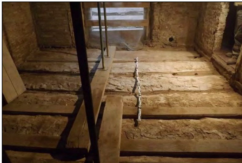
Paviments i embigat i revoltons de l'Àmbit 28
