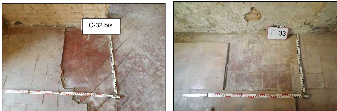
A l'esquerra la Cala 32 bis i vista de la Cala 33 a la dreta
