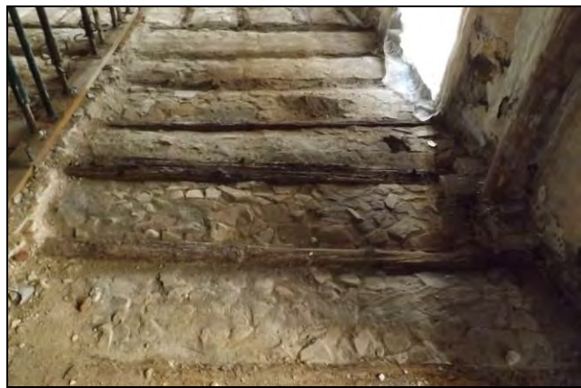
Àmbit 9 i dos amb el paviments original i el forjat
