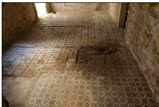
Dues vistes dels paviments de rajola hidràulica dels Àmbits 27 i 4
