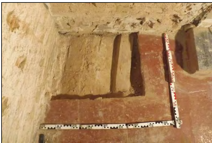
Vista de la Cala 22
