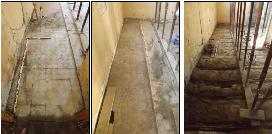
Àmbits 1 i 2 amb els darrers paviments, els paviments originals i els forjats
