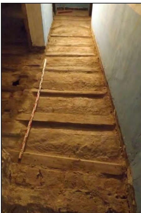
Àmbit 6. El paviment i el forjat de bigues i revoltons
