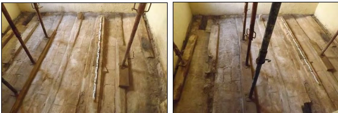
A Imatges del forjat amb la filera de maons
