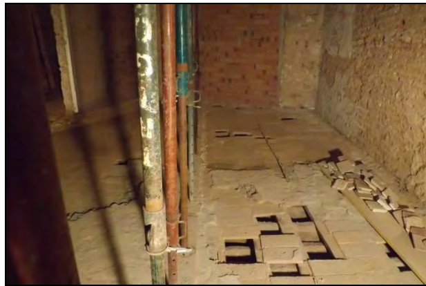
Vista del forjat de llates dels Àmbits 22 i 23
