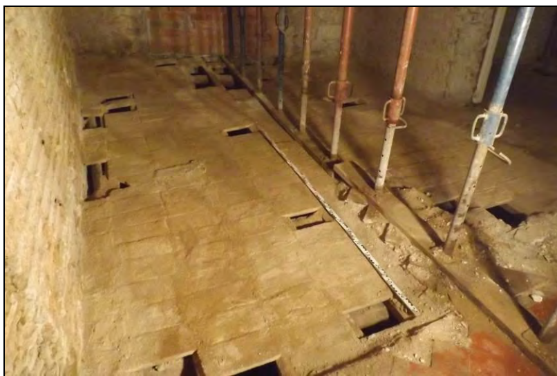
Vista del paviment i forjat de llatas de l'Àmbit 20
