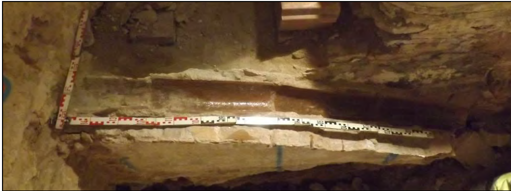
Vista de la canalització encofrada UE 14013
