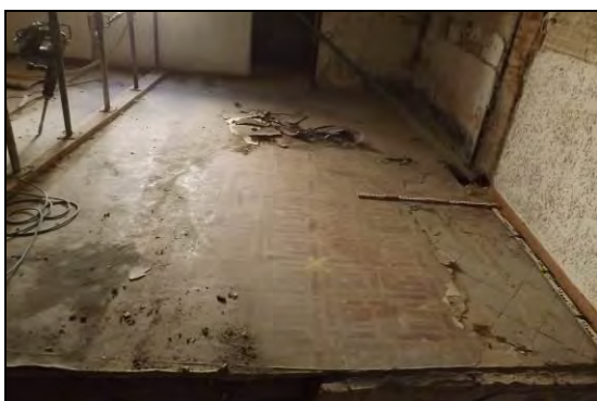
Àmbit 2a: L'esquerra el paviment vinílic i a la dreta els revoltons. A sota Àmbit 2a i 2b
