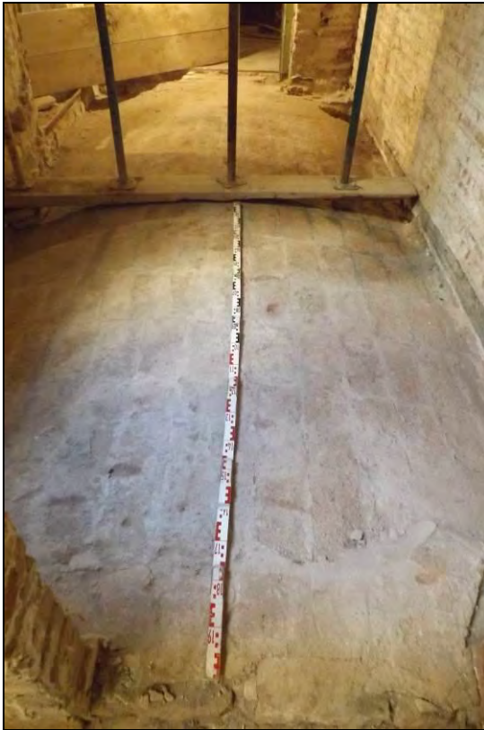
Vista de la colta de maons de l'Àmbit 27
