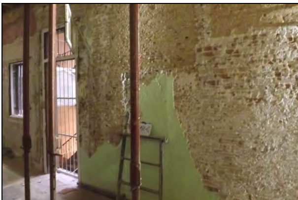
Vista del mur MR-C
