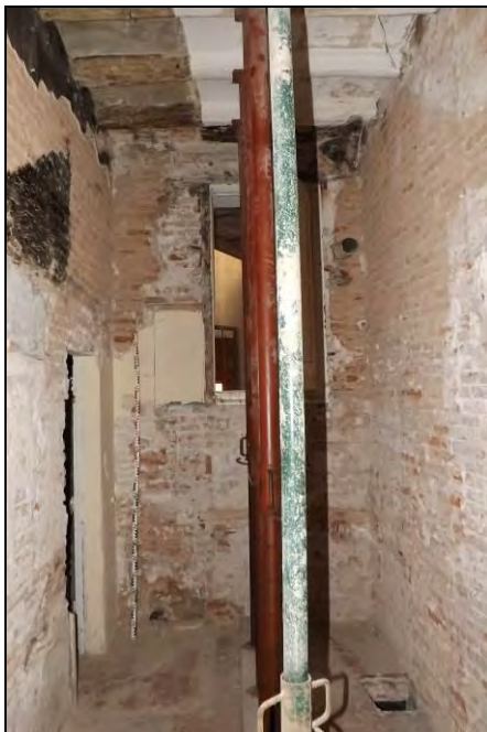
Vista del mur MR-C
