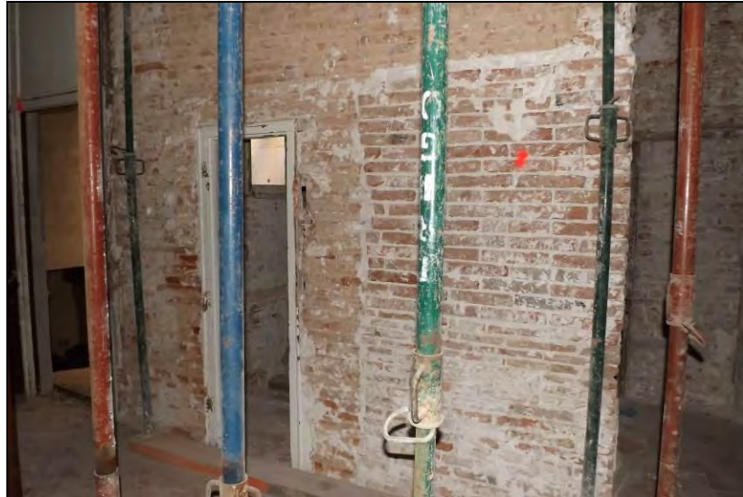
Vista del mur MR-C
