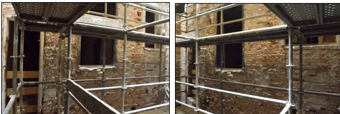
Planta Primera. Nivell inferior. Vistes del Mur Nord.
