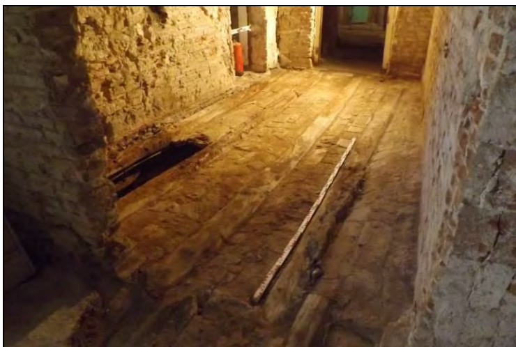
Vista general de l'Àmbit 24
