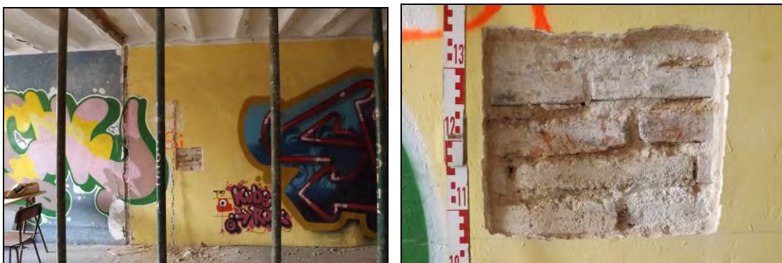
A l'esquerra vista general i a la dreta detall de la CP 18
