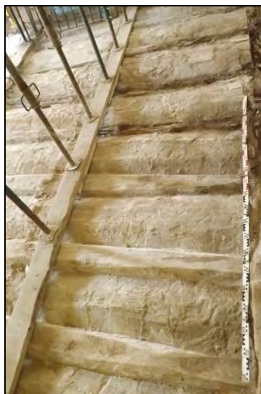
El paviment de l'Àmbit 8 i el forjat
