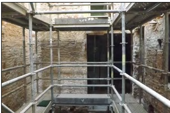
Planta Segona. Croquis Mur Oest i vista general alçat mur i detall porta tapiada
