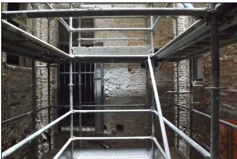
Planta Primera. Nivell inferior bastida. Foto Mur Est.
