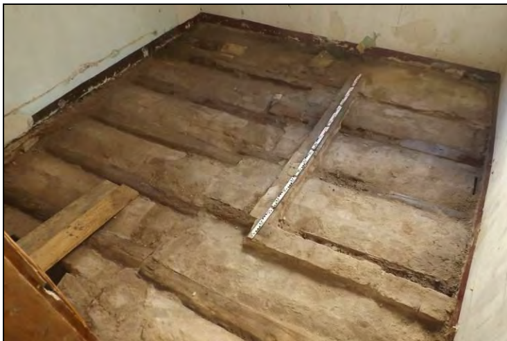
Vista del forjat de l'Àmbit 4
