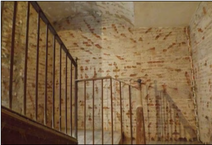
Vista en alçat del mur Est
