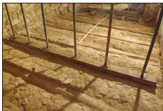
Vista de l'embigat amb la reparació i els envans de re creixement i vista general
