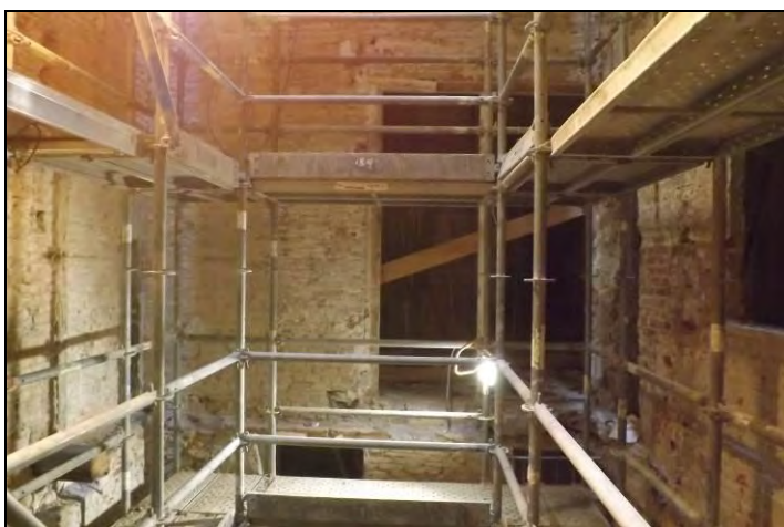
Replà Planta Principal i Altell. Mur Oest. Foto general
