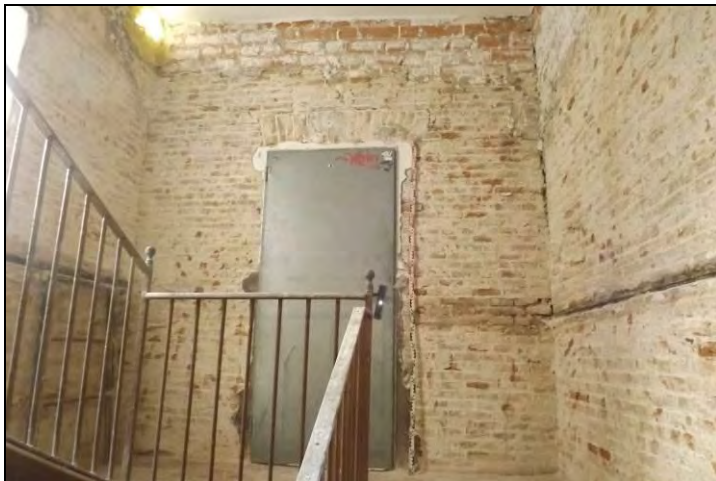
Vista en alçat del mur Est amb la porta que dona al terrat
