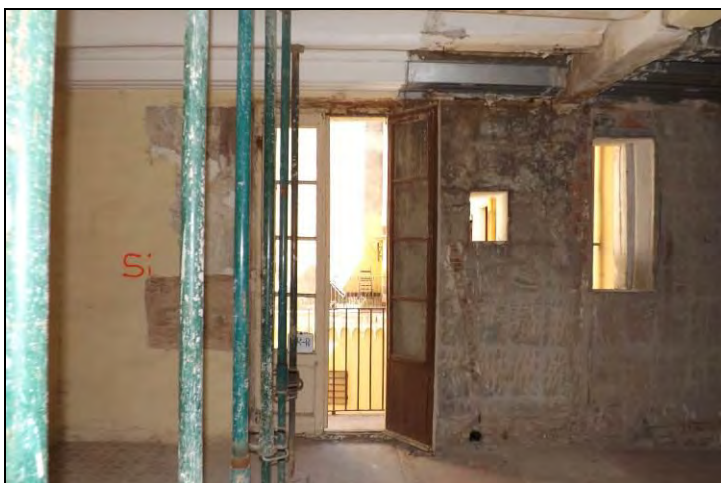
Vista del mur MR-R
