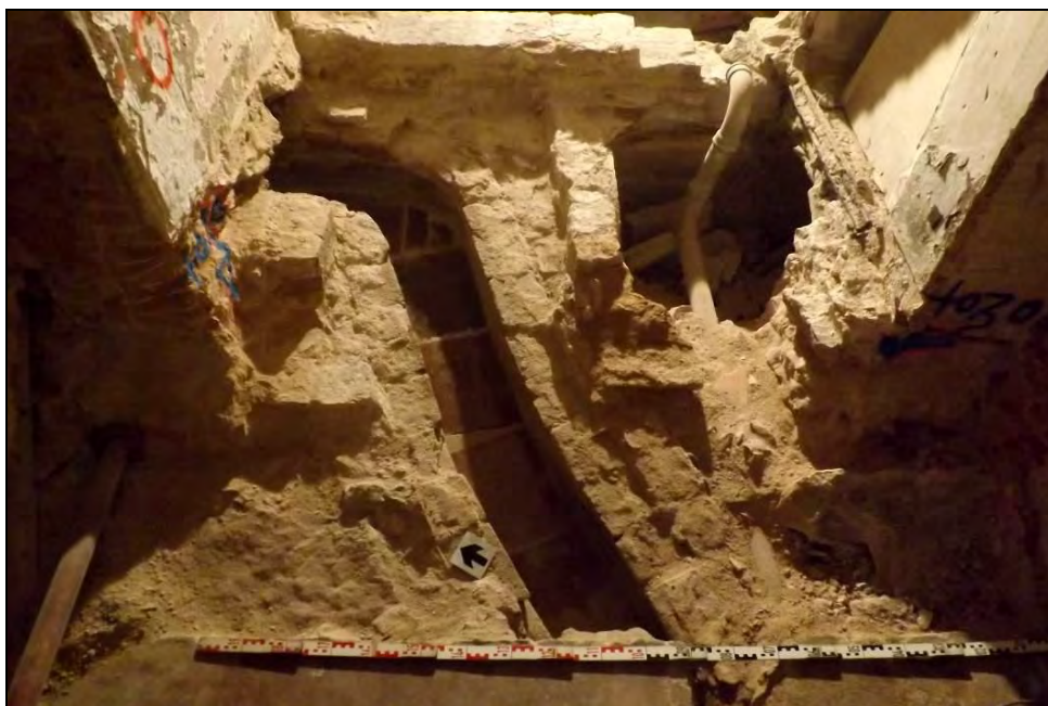
Vista en planta de la claveguera UE 14015 i les restes del dipòsit UE 14007
