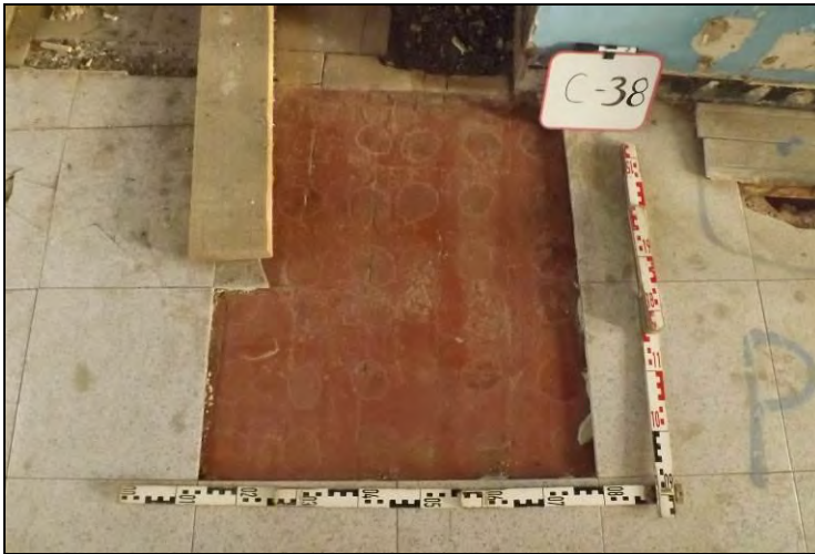
Vista de la Cala 38
