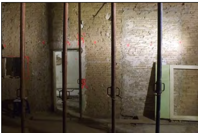
Vista del mur MR-E
