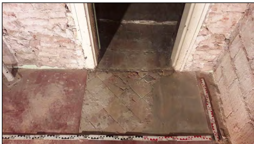
Vista de la Cala 7
