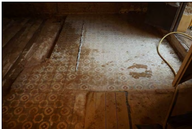
Vista del paviment de l'Àmbit 26
