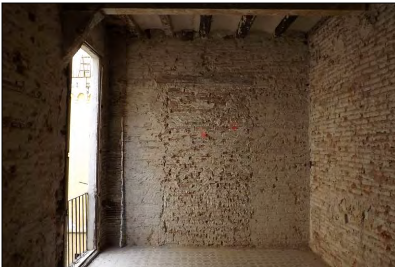
Vista del mur MR-V
