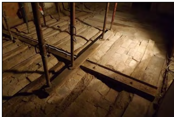
Vista del paviment de vinil i l'embigat de fusta amb el reforç de la biga de ferro
