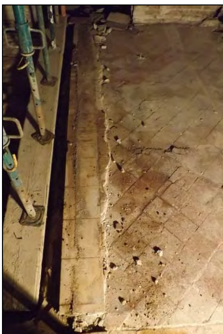
Vista dels paviments sobreposats a l'esquerra i a la dreta el forjat
