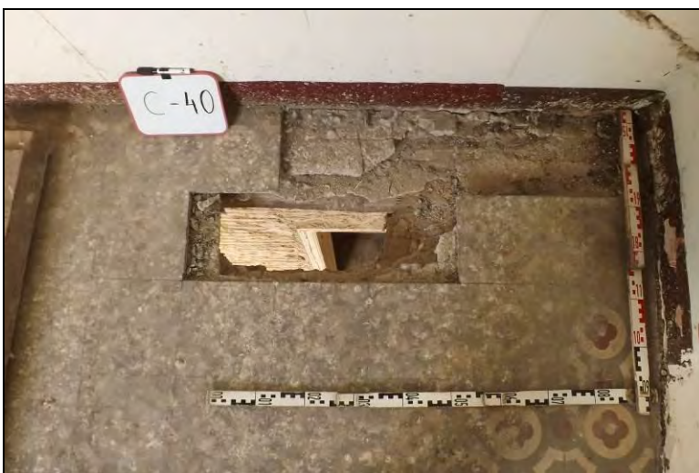
Vista de la Cala 40
