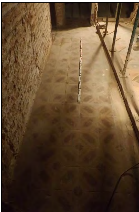
Dues vistes del paviment hidràulic i l'embigat de l'Àmbit 5
