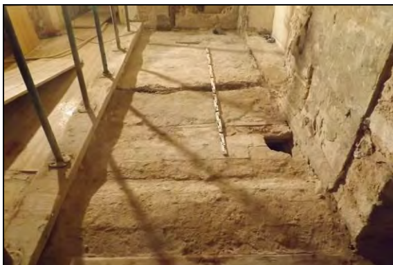
Vista final dels Àmbits 15, 16 i 17
