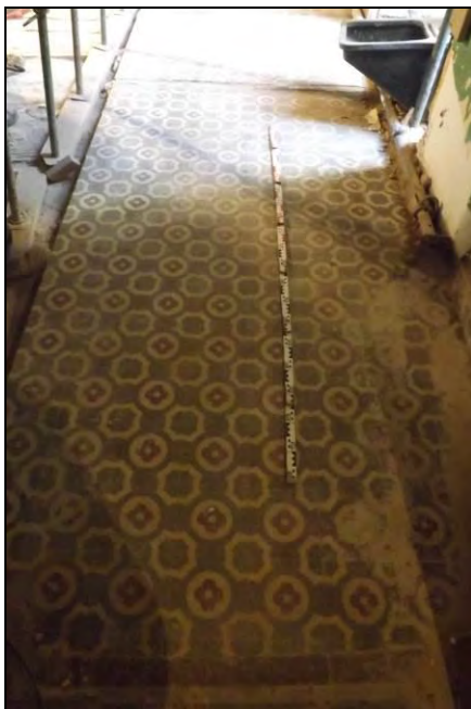
A l'esquerra el paviment hidràulic i a la dreta l'embigat amb els revoltos
