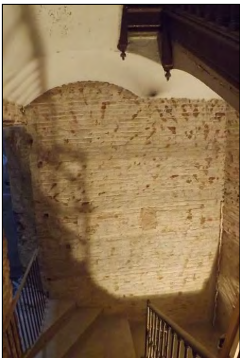
Vista en alçat del mur Est
